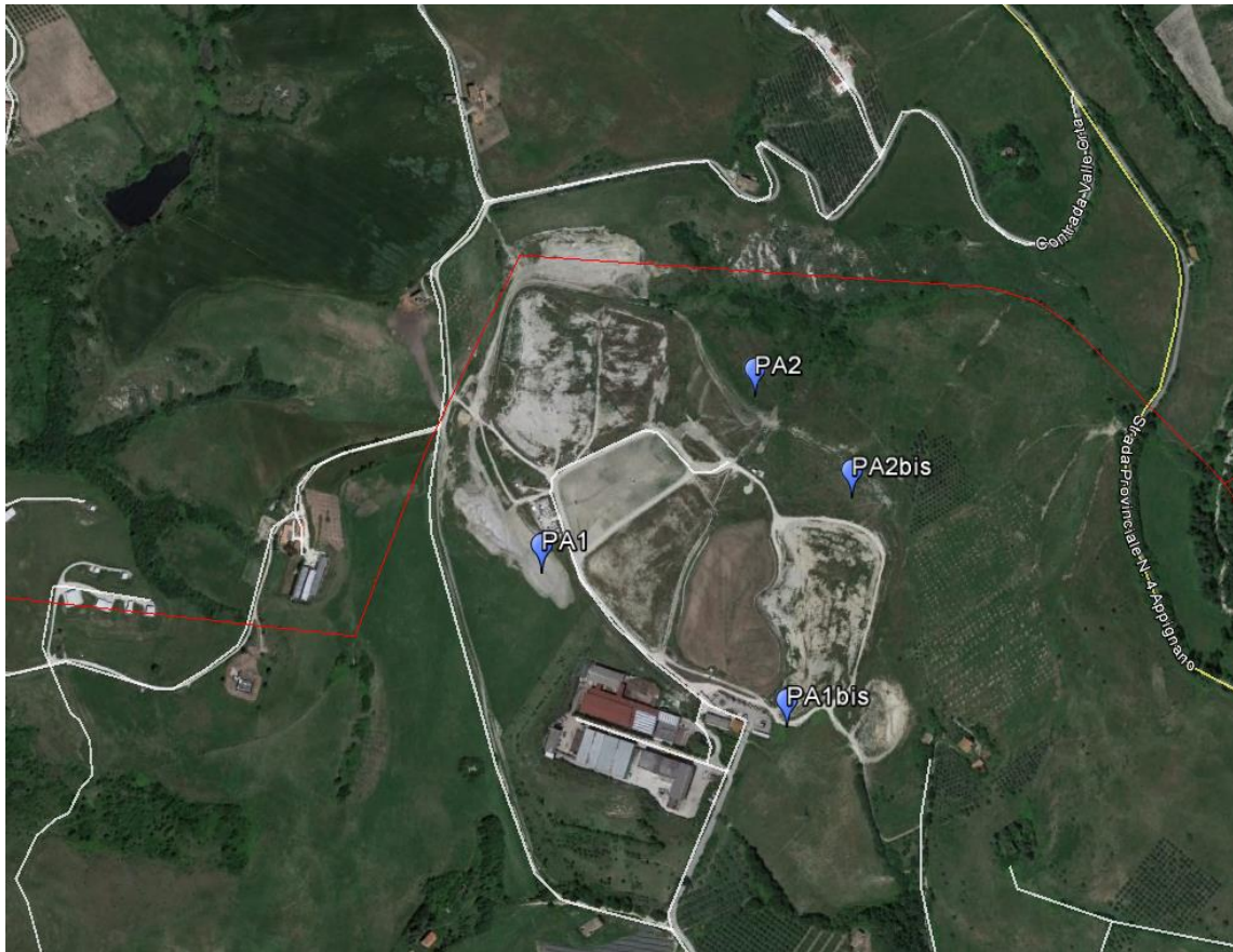
Figura 10.2 – Individuazione punti di campionamento per la determinazione della qualità dell'aria all'interno del polo di Relluce.
